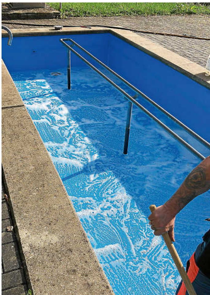
Bauhof beim Herrichten des Tretbeckens
