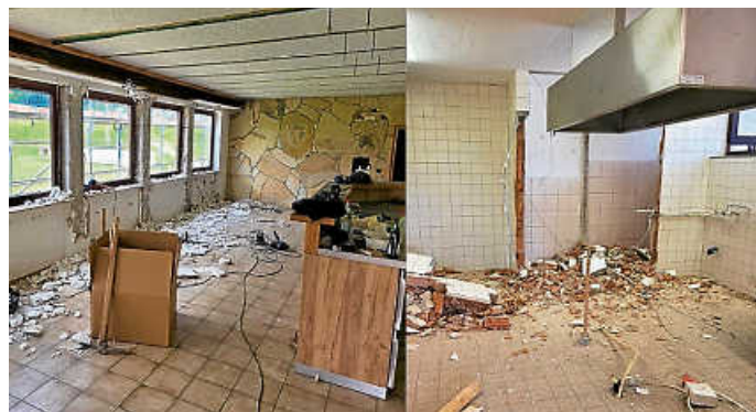
Baustelle – aktueller Stand
